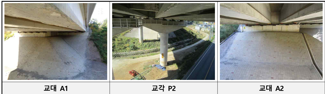
[교대 및 교각 전경]
