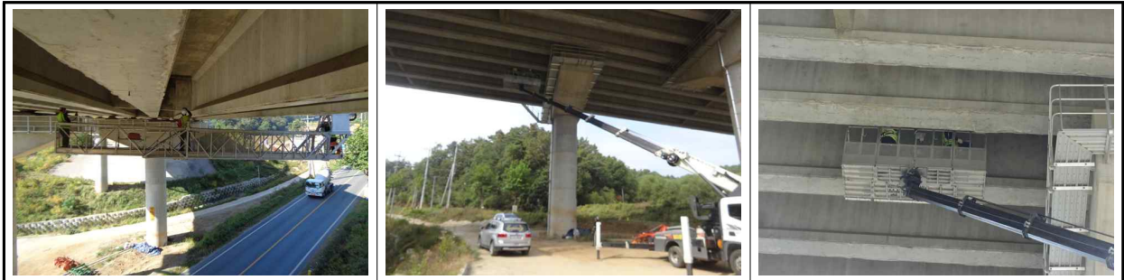
[고소작업차, 굴절점검차를 이용한 근접조사 실시]
